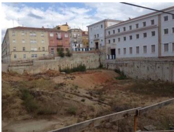
Fig. 2 El instituto en obras con su patio en primer plano. Foto: Voces de Cuenca, 30-01-2015.
