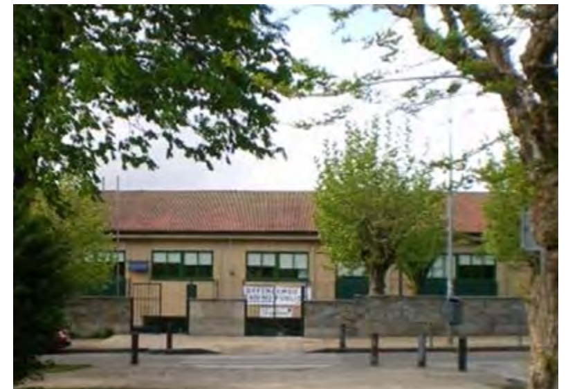
Fig. 4. Edificio actual del IES Arcebispo Xelmírez I.
