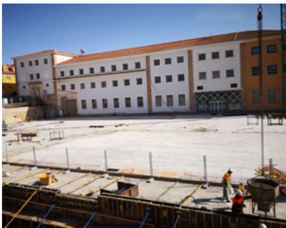
Fig. 6. Obras en el IES Alfonso VIII. Febrero, 2019
