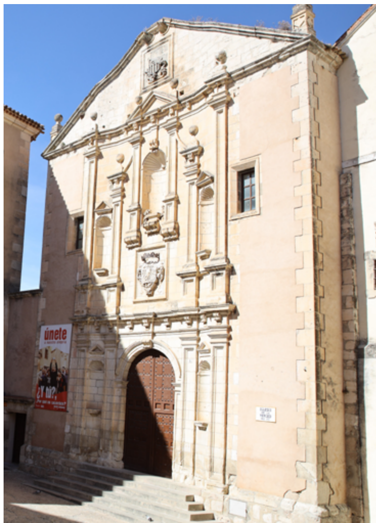
Fig. 1. Fachada de la iglesia de la Merced
